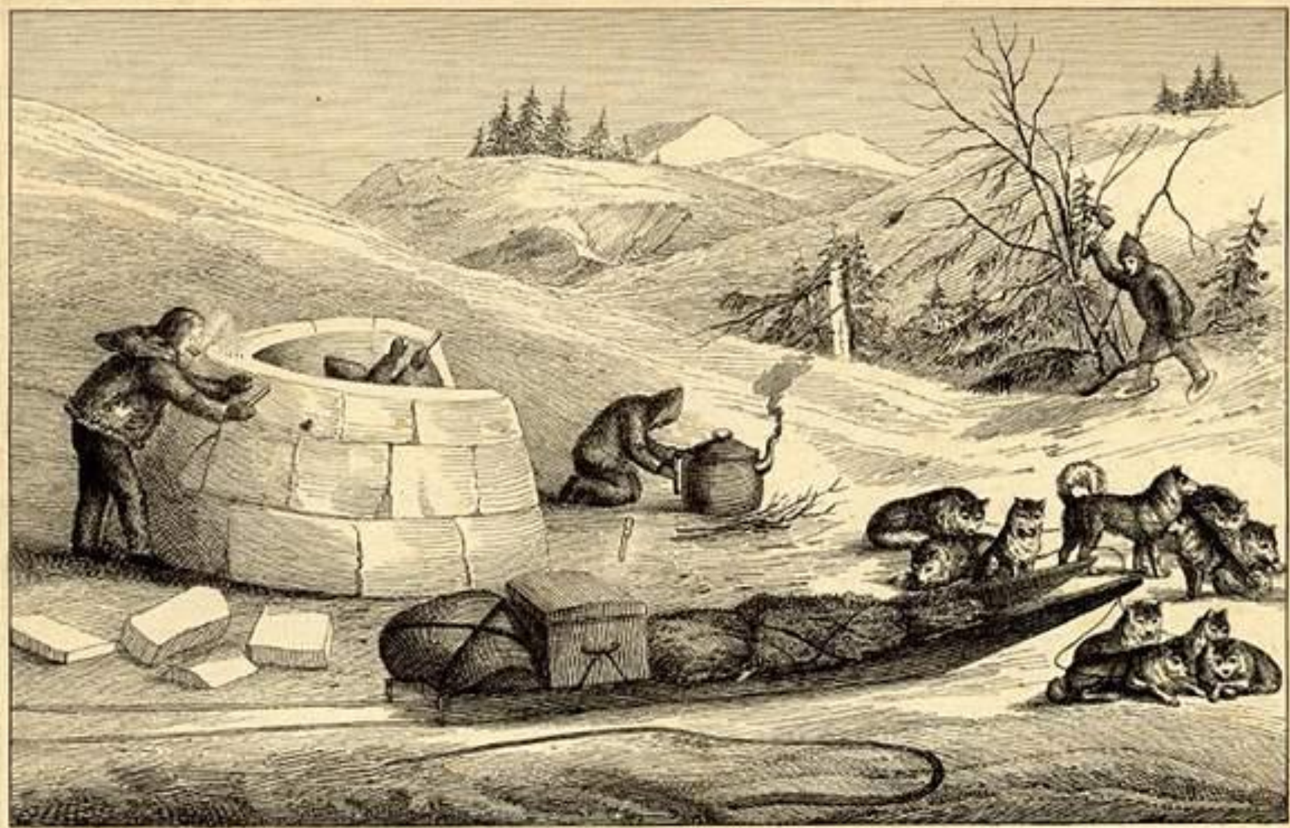
Erbauung eines Schneehauses in LABRADOR.
